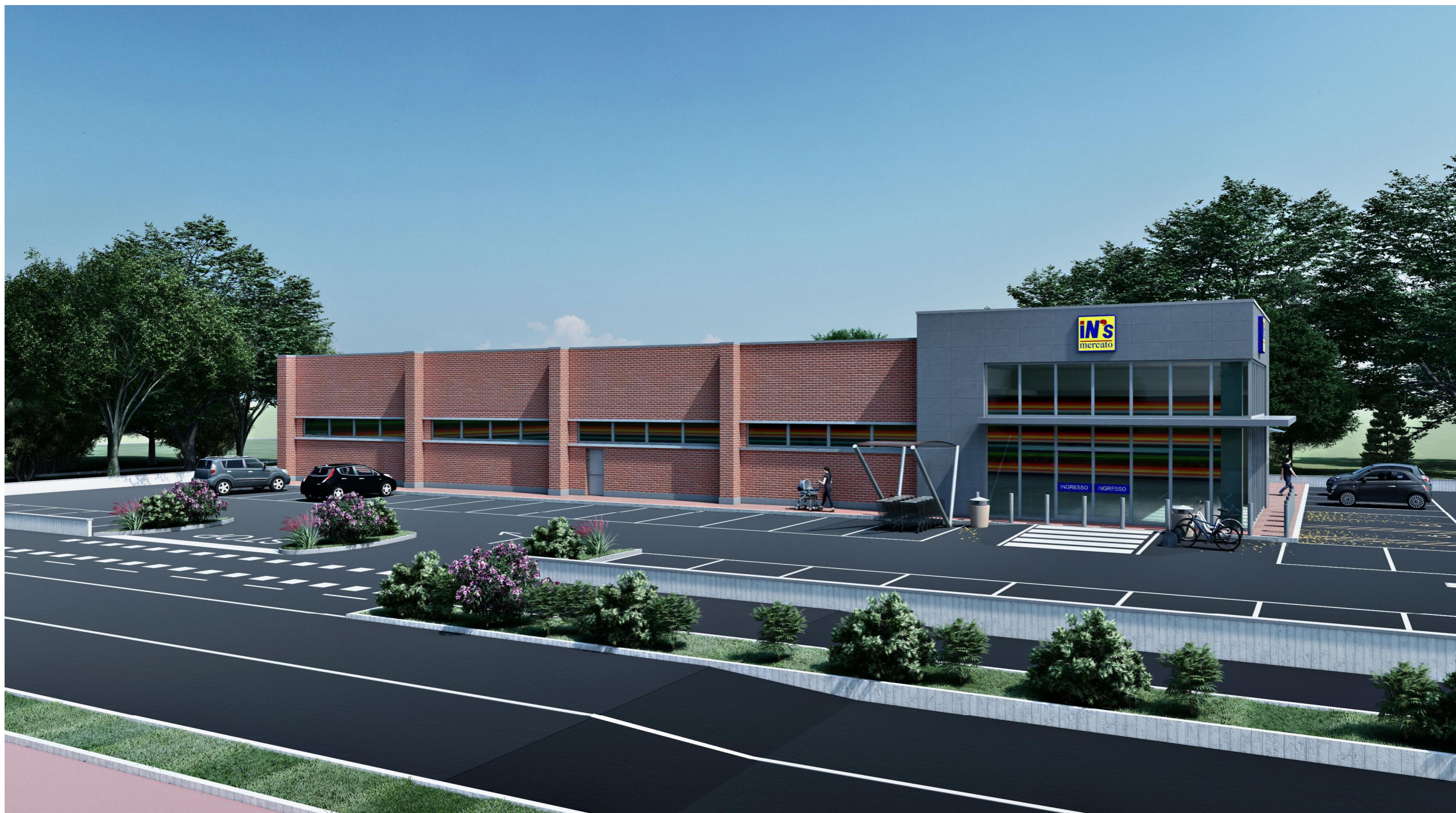
VISTA DA NORD EST DEL NUOVO EDIFICIO
