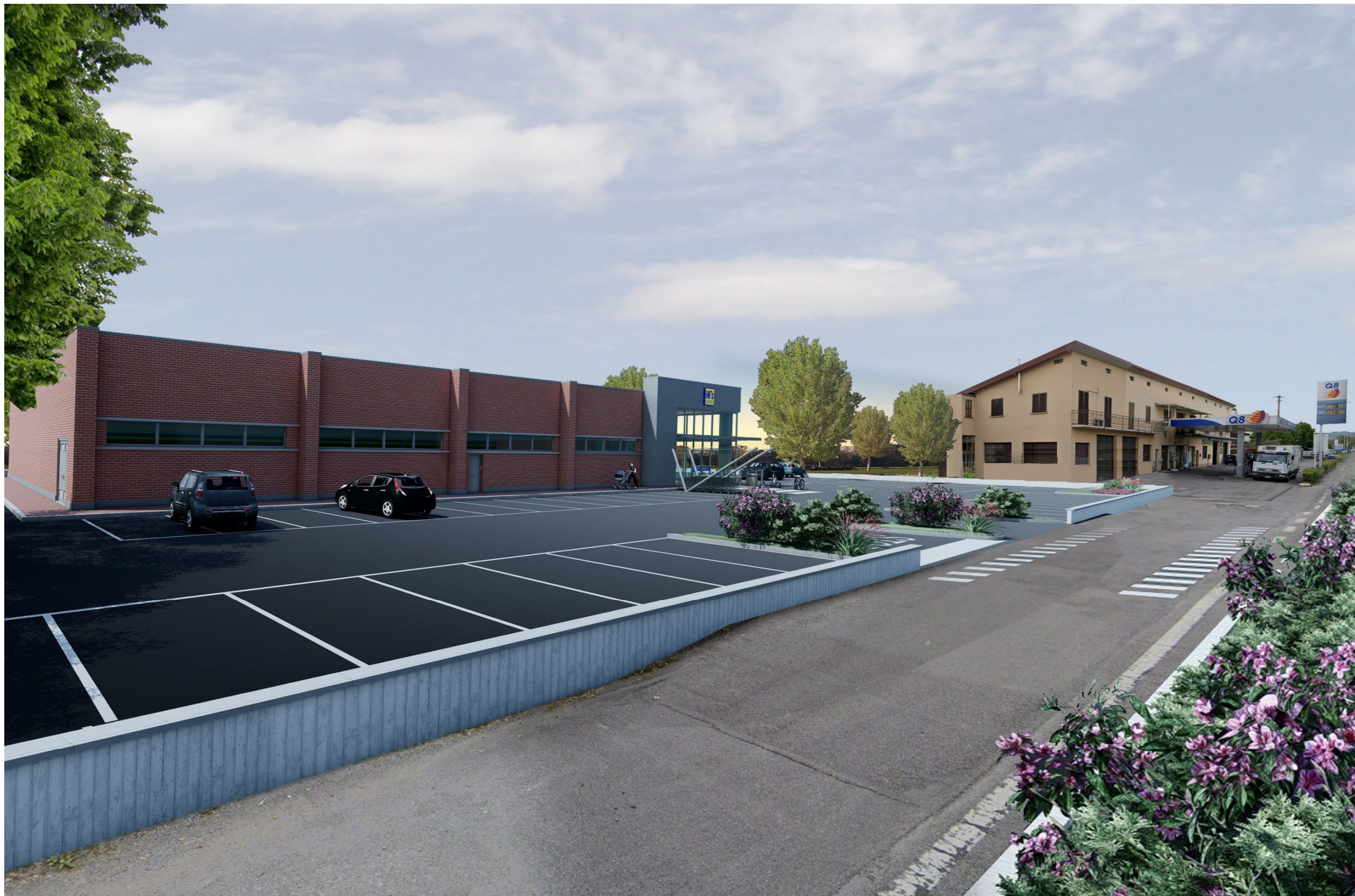
VISTA SUD EST CON IL NUOVO EDIFICIO
