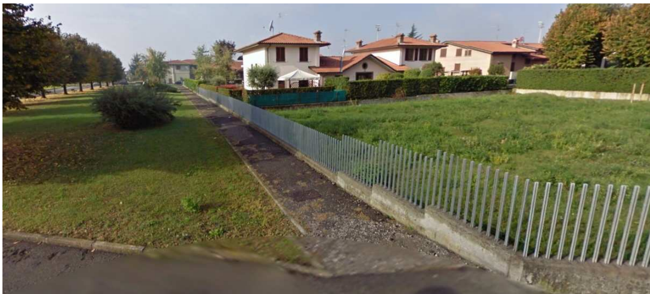
Area 4- Rifacimento pavimentazione pista ciclopedonale. Stato di fatto.
