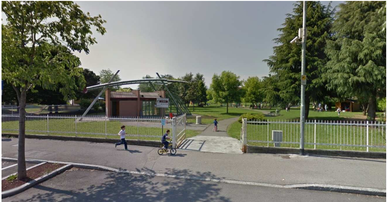
Ingresso Parcobaleno. Stato di fatto.
